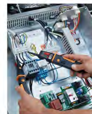
测量压缩机电压
