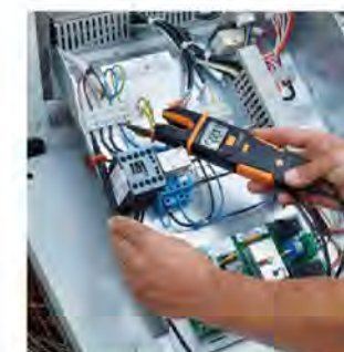
测量压缩机电压
