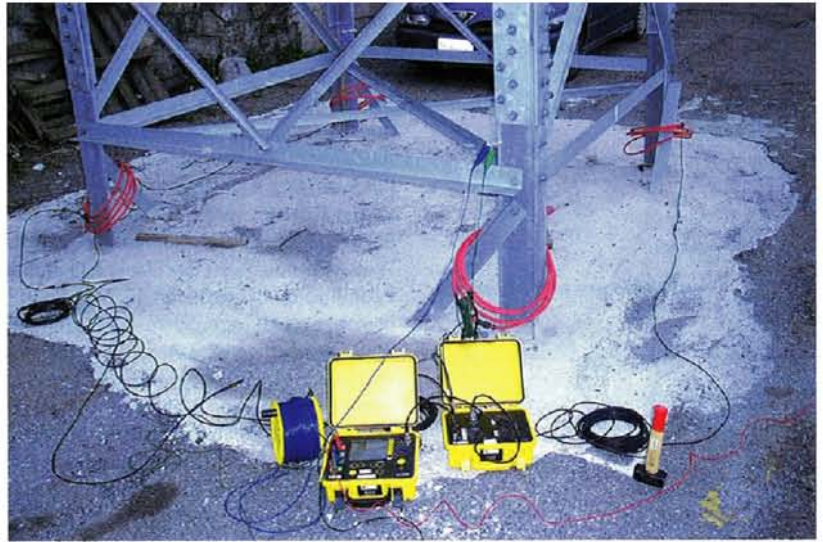
Abb. 2. Selektive Erdungsmessung eines Mastes mittels Rogowski-Spule
