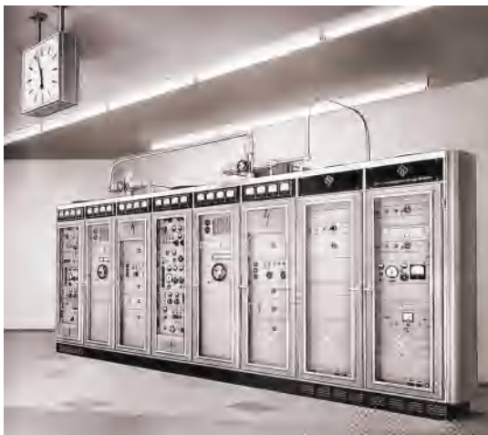
1963: VHF radio transmitter with mit 2 \times 5 kW
