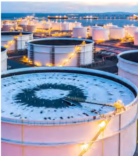
危化品储罐区
