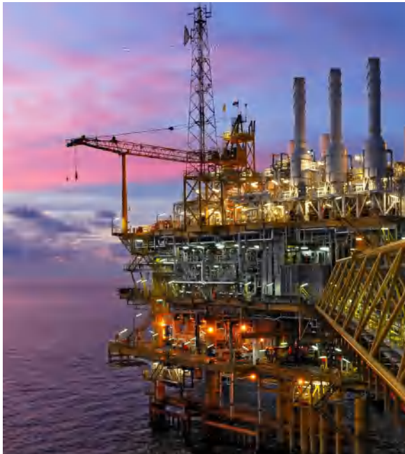
海上石油平台
