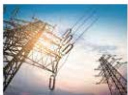
电力设备巡检
