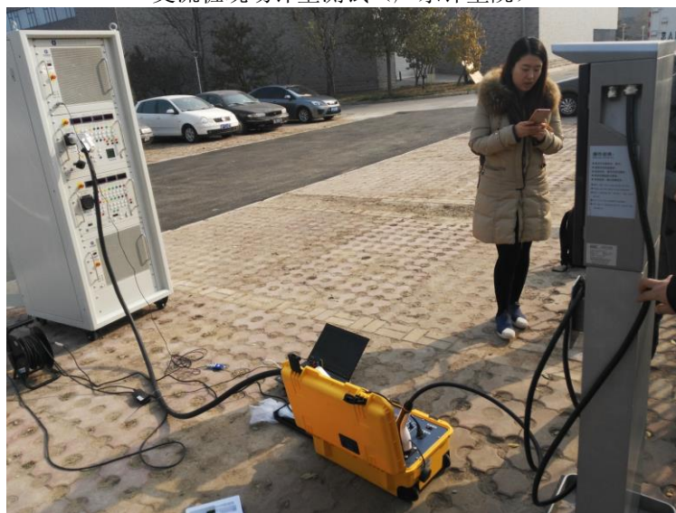
交流桩现场计量测试 (4所(赛西)实验检测中心)
