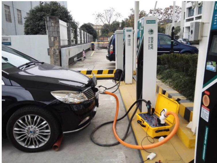
直流桩现场计量测试（浙江华电器材检测所）
