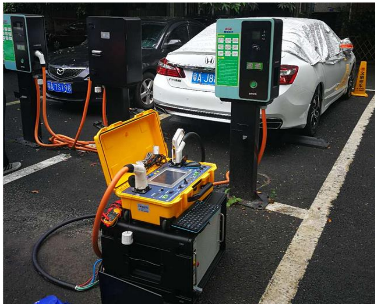
直流桩现场计量测试（广州计量院）
