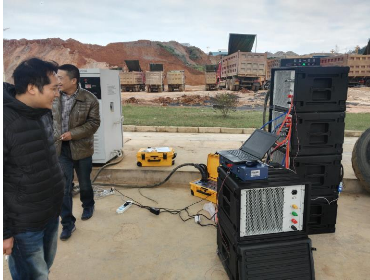
直流桩现场计量测试（贵州计量院）
