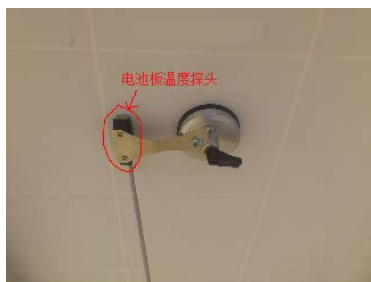
图 3.6 方形温度探头安装示意图
