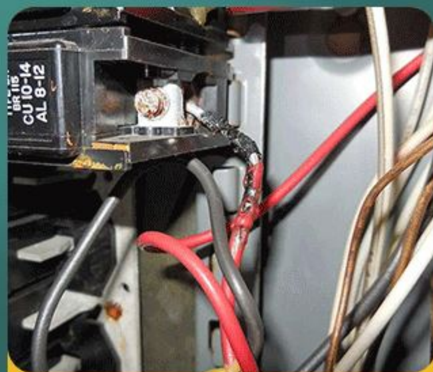
电路老化，短路
