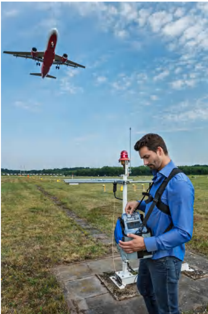
ILS measurements on an ILS monitoring antenna
