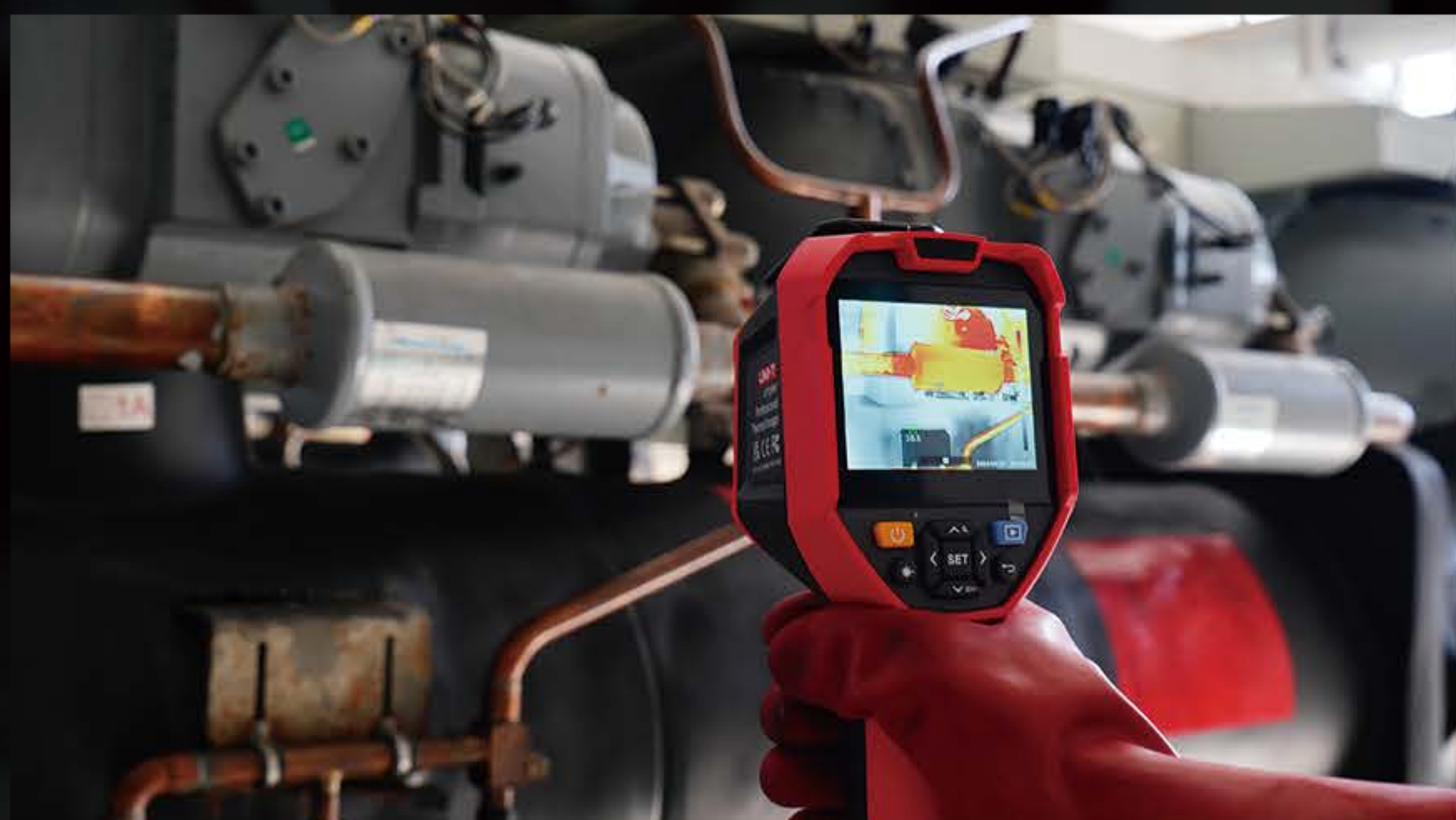
管道温度筛查检测
