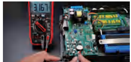
电子电路检修
