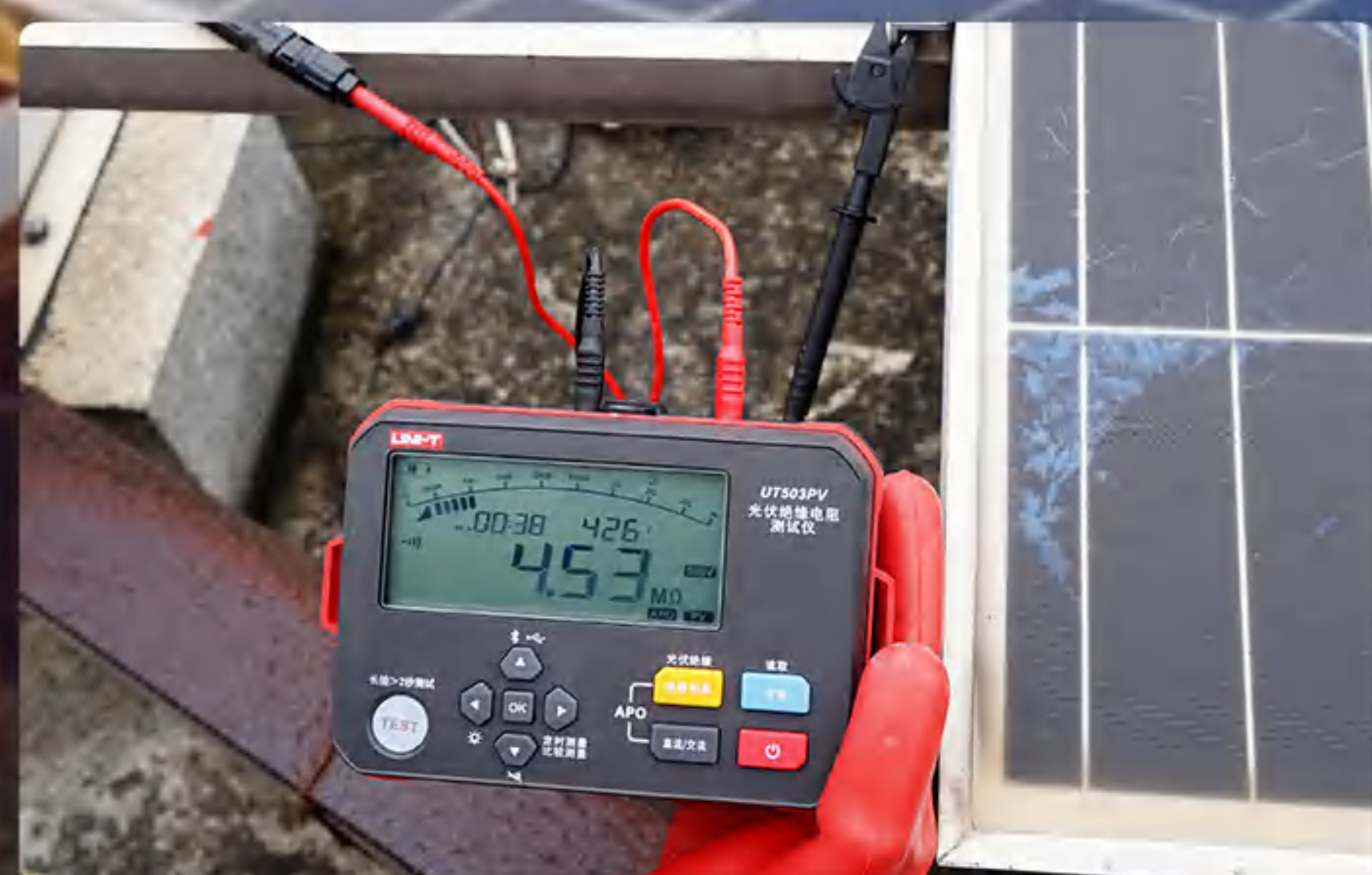
光伏组件绝缘测量
