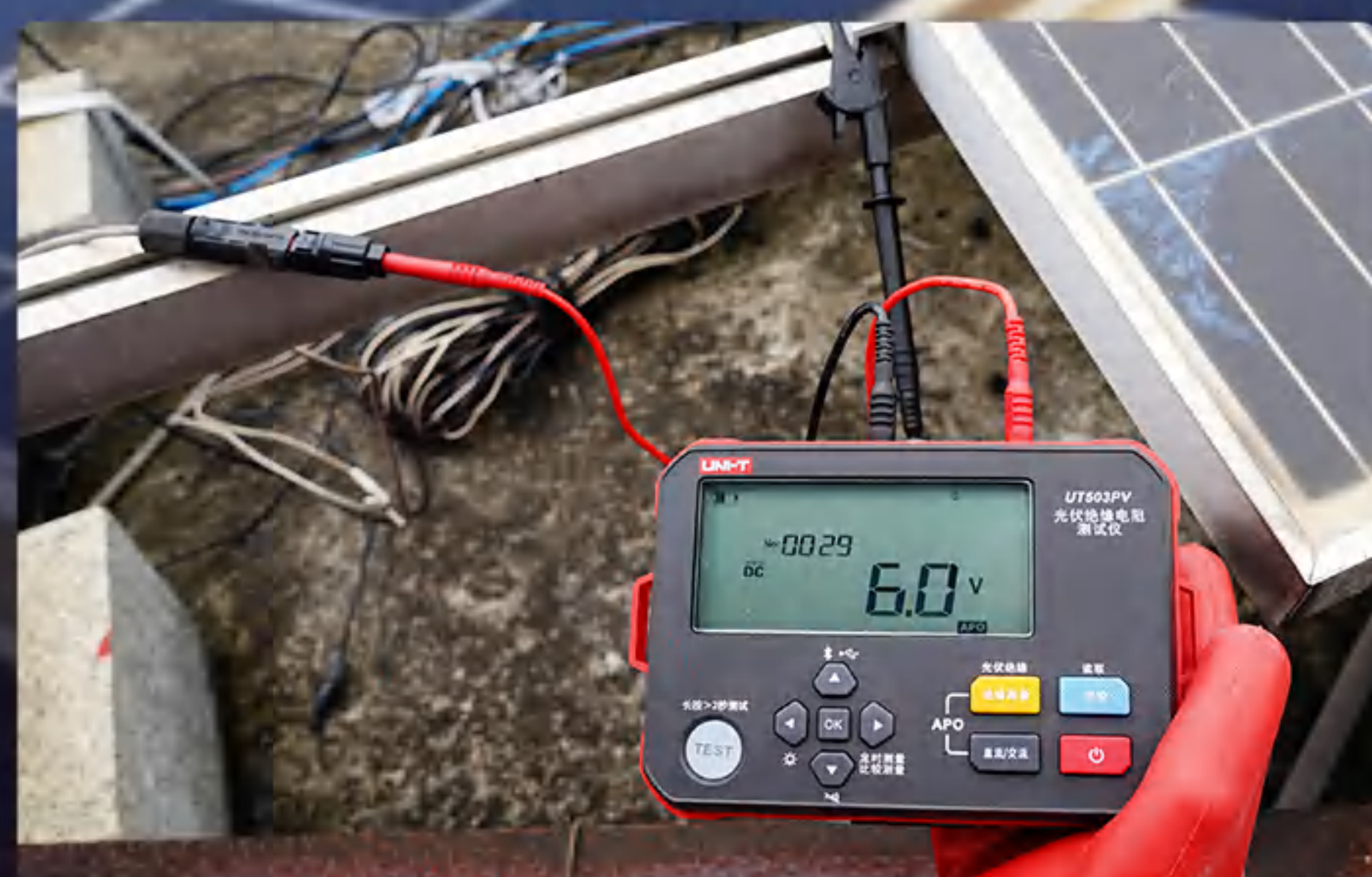
光伏组件接地电压测量
