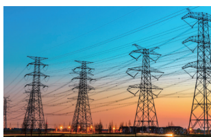
电力设备巡检
