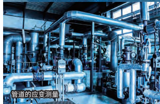
制动和配管的应变测量
