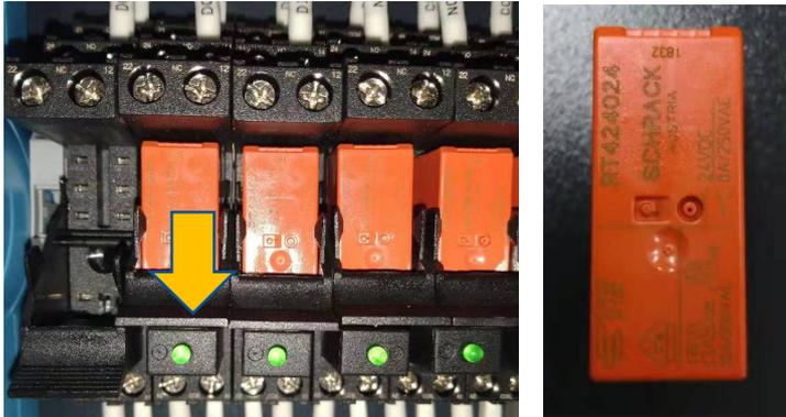
(2) 注意继电器针脚，将新品装入继电器座中，接着往上扳继电器座开关，按照顺序完成所有继电器的更换按照。
